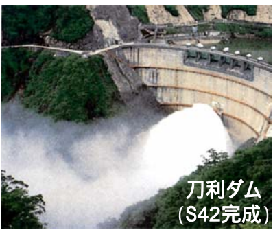
既設洪水調節施設
