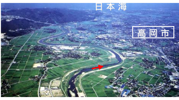
下流部の蛇行状況
