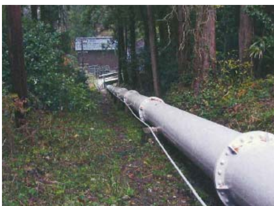
▲発電所へ向かう導水管の状況
