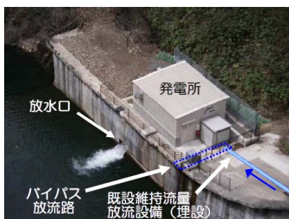
▲ 発電所設置後の現況
