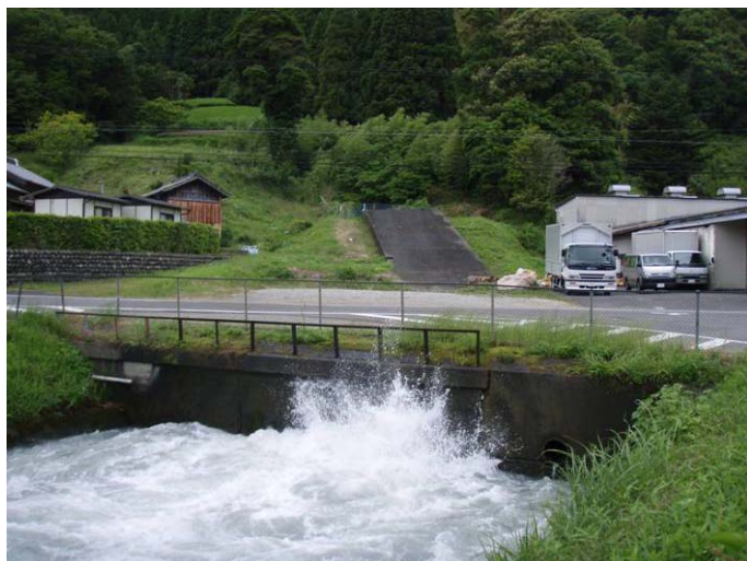
▲ 発電所設置前の状況
