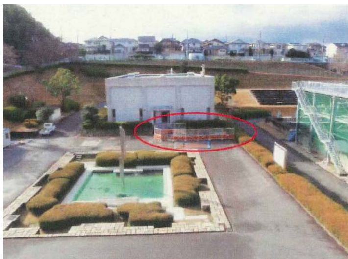
▲ 発電所設置前の状況
