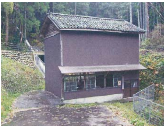
▲発電所建屋の状況
