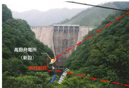
▲ 発電所設置前の状況
