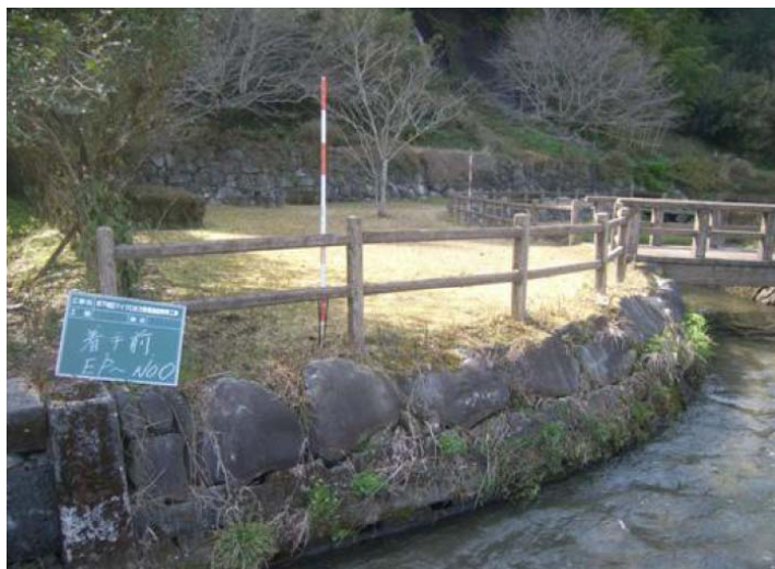
▲ 発電所設置前の状況
