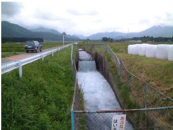
▲ 発電所設置前の状況
