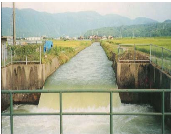
▲ 発電所設置前の状況
