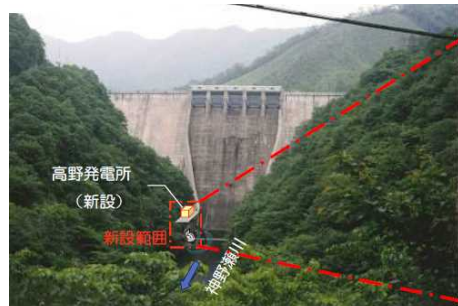
▲ 発電所設置前の状況
