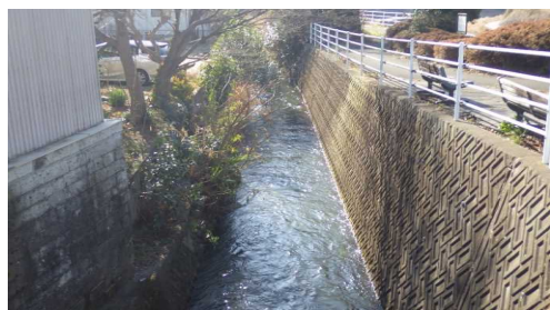
あかさ川上流（栃木県）
