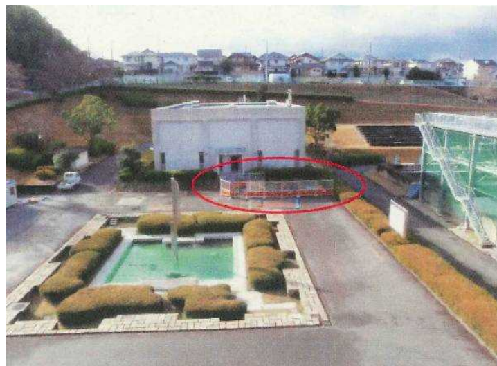
▲ 発電所設置前の状況
