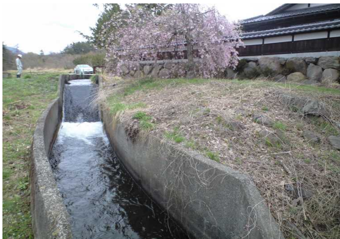
▲ 発電所設置前の状況
