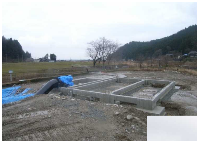
▲ 発電所設置前の状況
