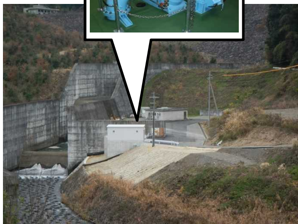
発電所設置後の現況 ▶
