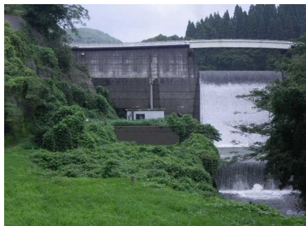
▲ 発電所設置前の状況
