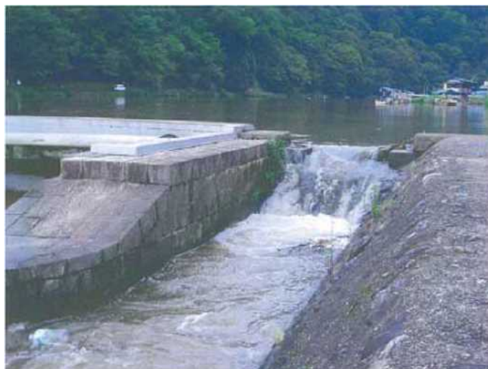
▲ 発電所設置前の状況
