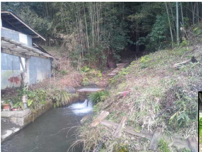
▲ 発電所設置前の状況
