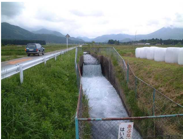
▲ 発電所設置前の状況
