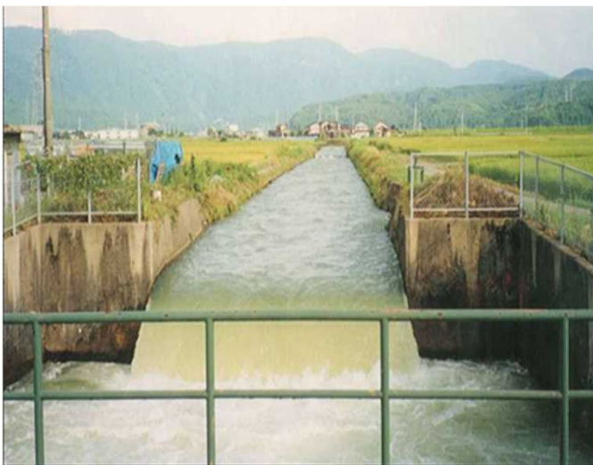
▲ 発電所設置前の状況
