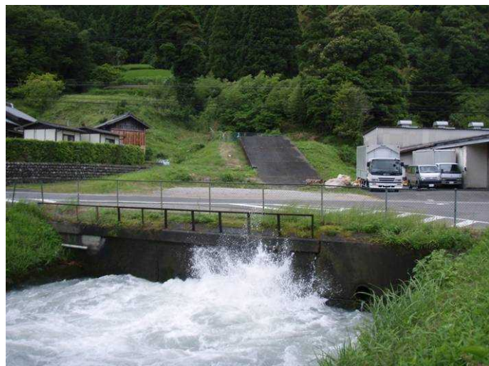
▲ 発電所設置前の状況
