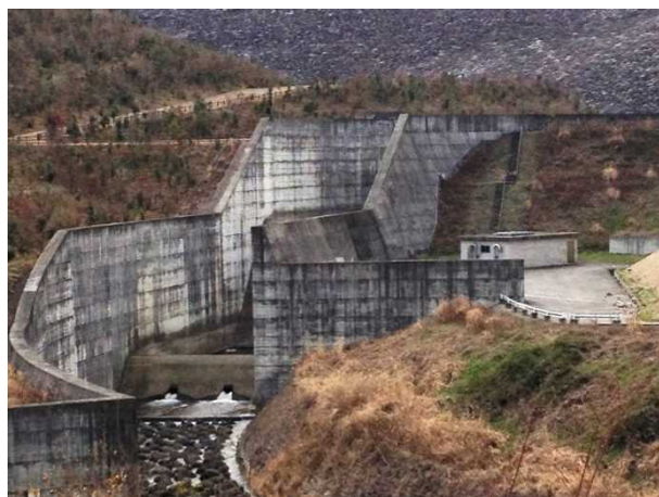
▲ 発電所設置前の状況
