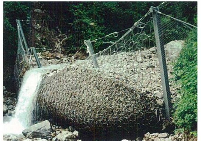
土石流の捕捉状況
