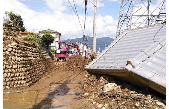
堆積土砂の除去状況
