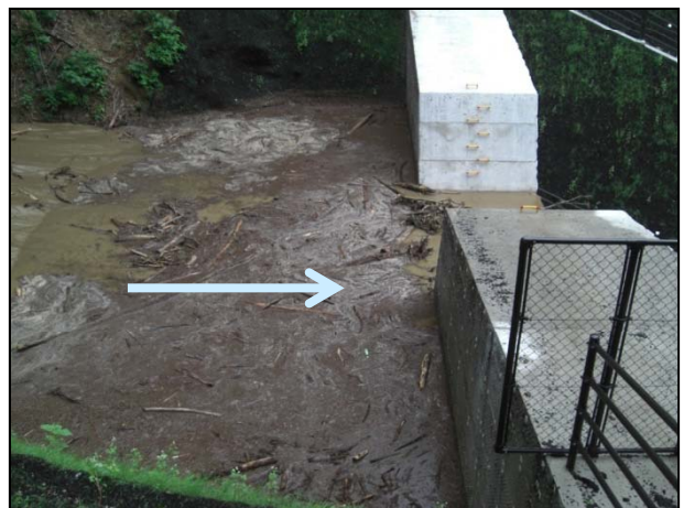
土石流発生直後 (H26. 8. 20)
