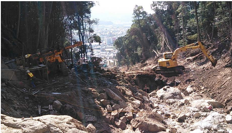
強靱ワイヤーネット工施工状況 (アンカー孔掘削中) (小原山川 八木3丁目)
