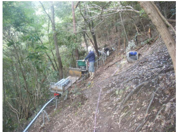
強靱ワイヤーネット工施工状況 (モノレール設置中) (神宮川 緑井7丁目)
