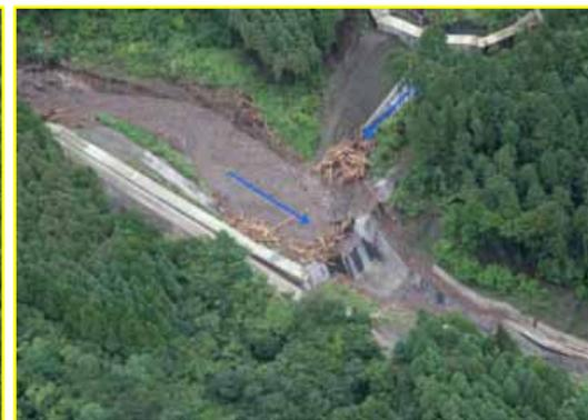
2号堰堤における土砂等捕捉状況
