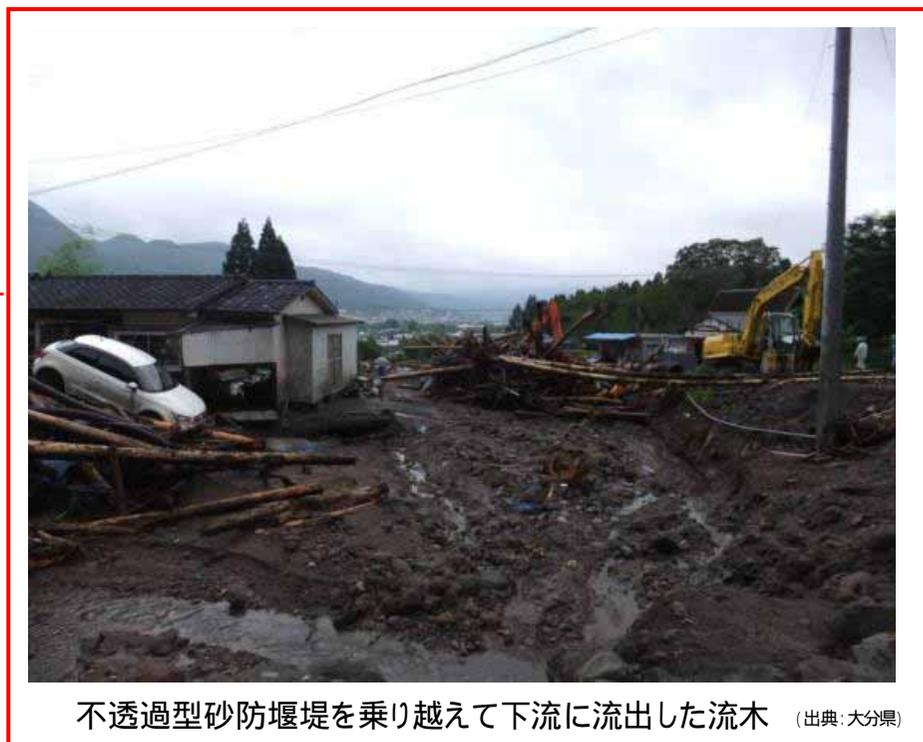
不透過型砂防堰堤を乗り越えて下流に流出した流木
