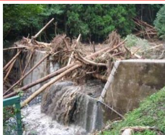
既設砂防堰堤による 流木の捕捉状況
