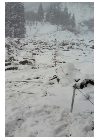
応急対策を実施 (土石流センサーの設置)
