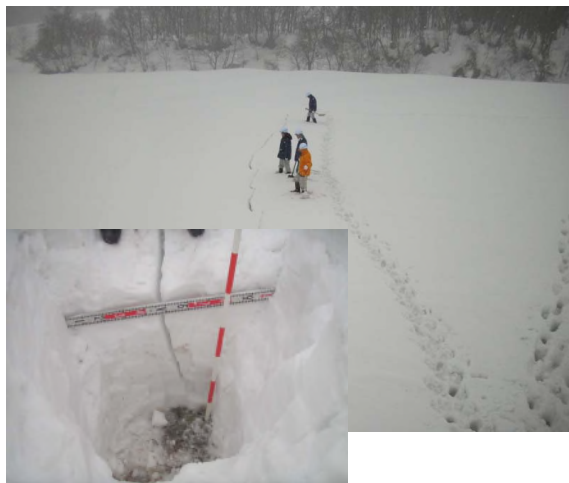
被災状況調査
