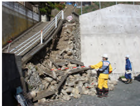
被災状況調査
