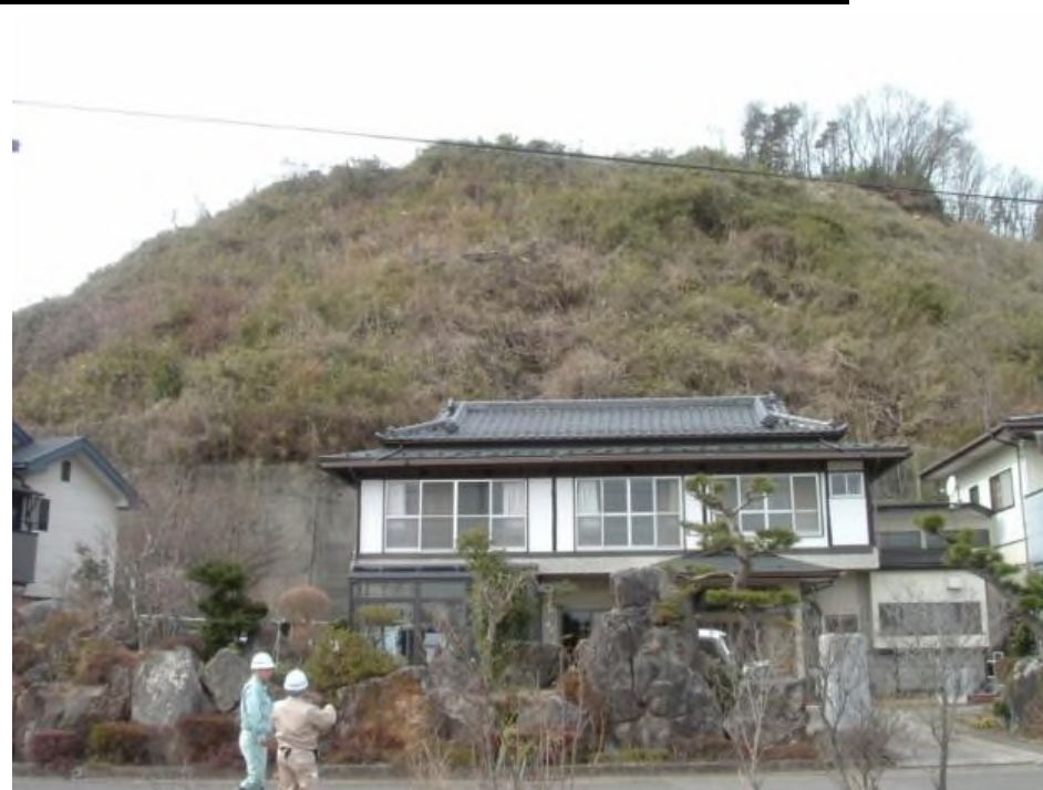
土砂災害危険箇所の点検状況
