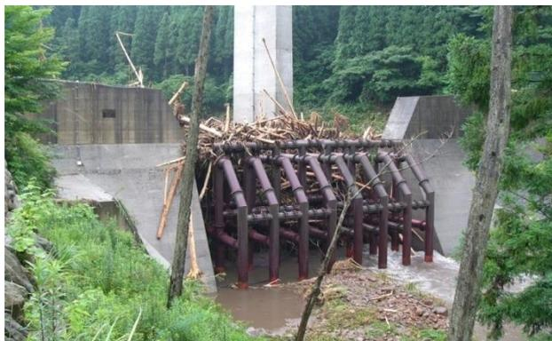
透過型砂防堰堤(熊本県小国町)
