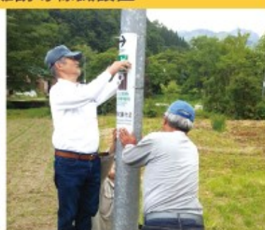
標識設置(真室川町)
