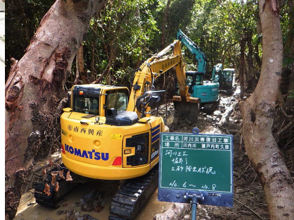
参考写真: 狭隘な現場 (複数の重機による転置)
