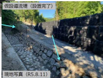
参考写真: 仮設導流堤 (設置完了)
