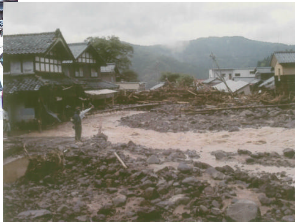
ふくいしじょうきょうじまち 福井市浄教寺町 流木をともなった土石流で家屋・道路等が被災。
