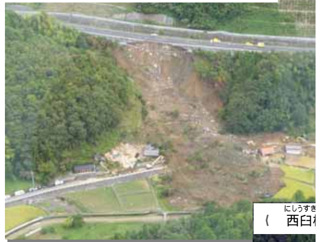
( いわくにし はたき 岩国市 廿木地区 (死者3名) 地すべり )
