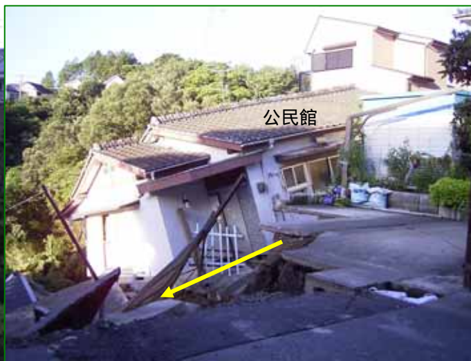
公民館・車が滑落、人家一部損壊 避難により人的被害なし
