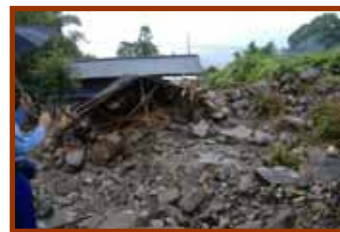
熊本県美里町志道原 (7月11日発生 梅雨前豪雨)
