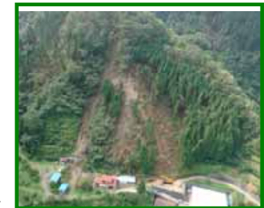
東京都西多摩郡檜原村藤原 (9月6日発生 台風第9号)
