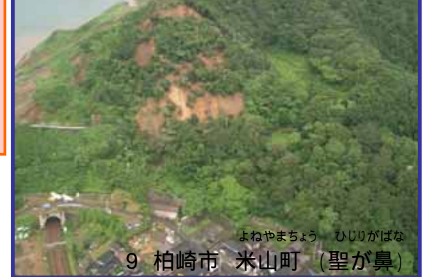
照明車、衛星通信車により監視中
