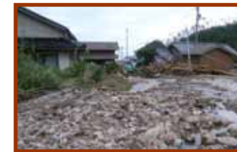
島根県隠岐郡 隠岐の島町都万 (8月31日発生 豪雨)
