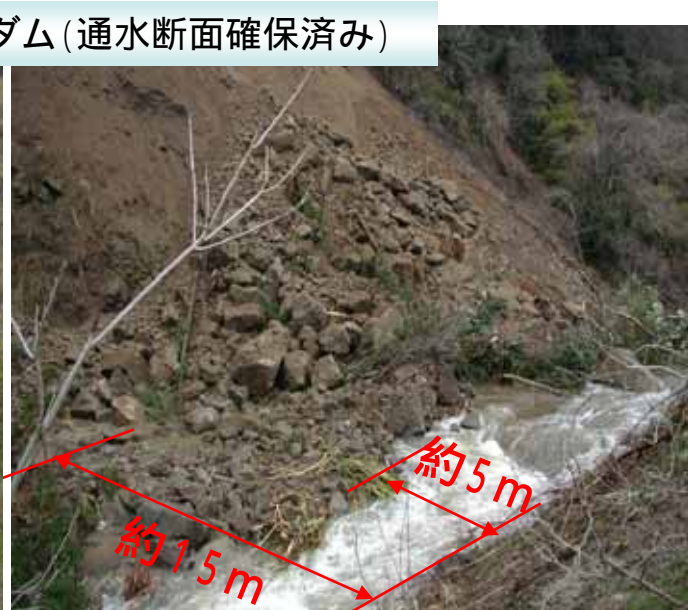
21.輪島市空熊町(空熊)天然ダム(通水断面確保済み)
