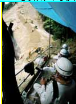
無人化施工（岐阜県施工） ～岐阜県揖斐川町東横山地すべり～ ぎふけん いひかわらちょう ひがしよこやま
