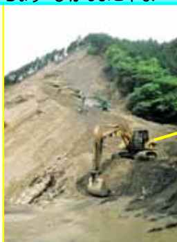
無人化施工（岐阜県施工） ～岐阜県揖斐川町東横山地すべり～ ぎふけん いひかわらちょう ひがしよこやま
