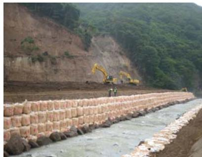
水路用追加大型土のう制作、据付け
