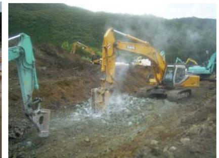
仮排水路掘削工(岩掘削)
