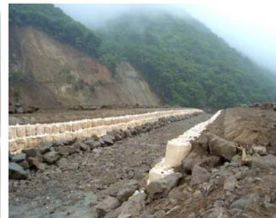
7/12出水による仮排水路損壊箇所の補修
