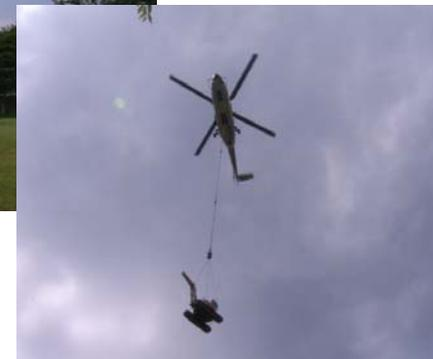
「**土研式投下型水位観測ブイ**」を用いヘリから直接水位計を設置
