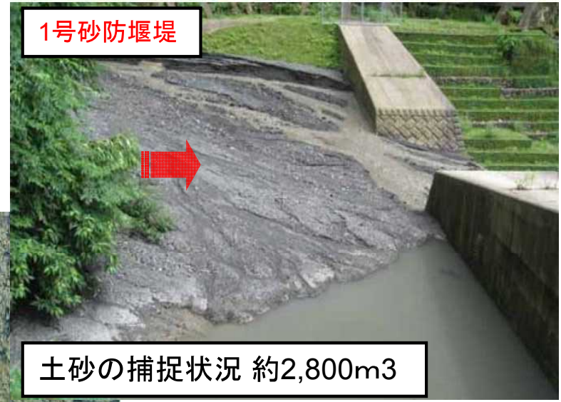
土石流の捕捉状況 〈平成22年7月16日撮影〉
