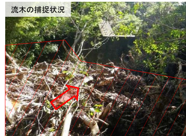
土砂の捕捉状況
