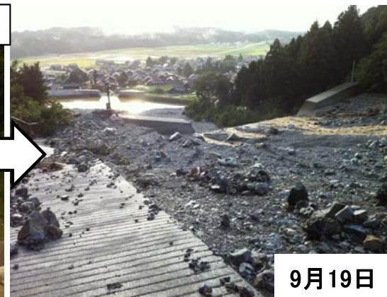
1号堰堤および遊砂地の土石流捕捉状況
