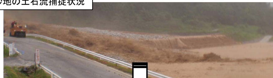
遊砂地の土石流捕捉状況
