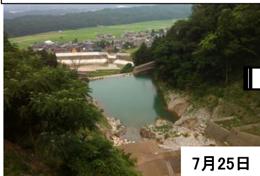
1号堰堤および遊砂地の土石流捕捉状況
