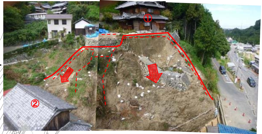
①崩壊した斜面の状況
