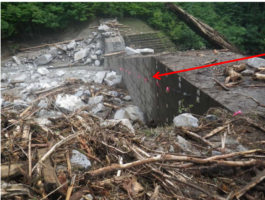
■土石流感知ワイヤーセンサー設置状況 (7月14日 梨子沢第1砂防堰堤)
