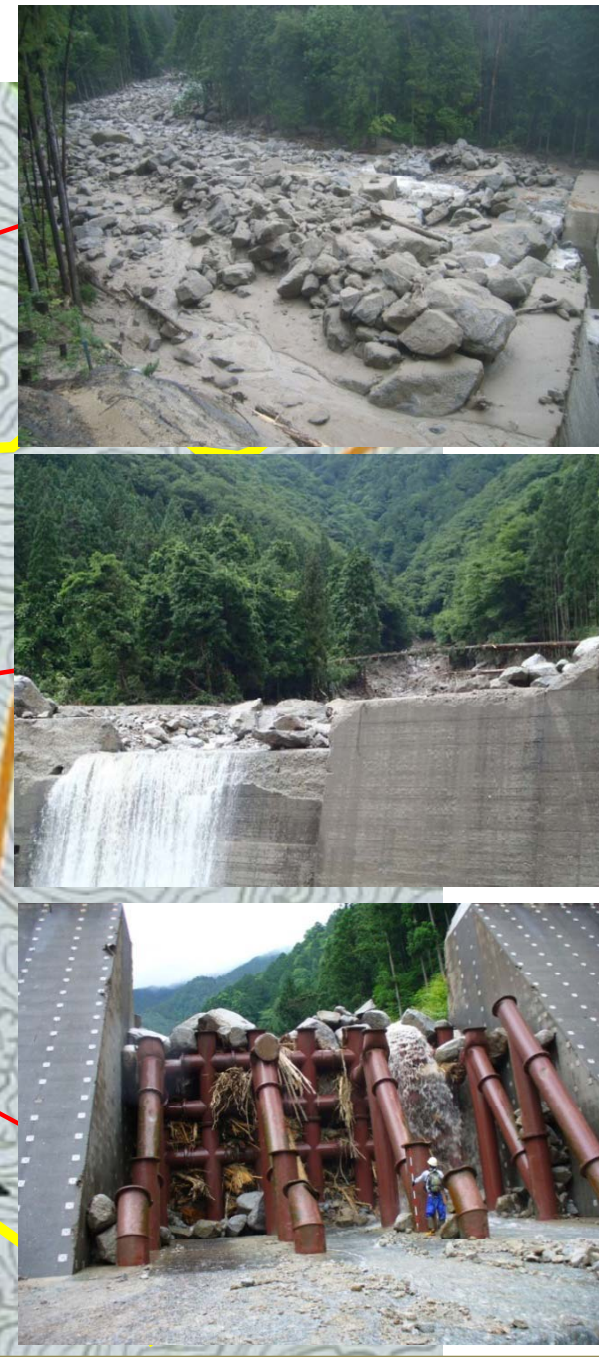
土石流発生後の砂防堰堤の状況
