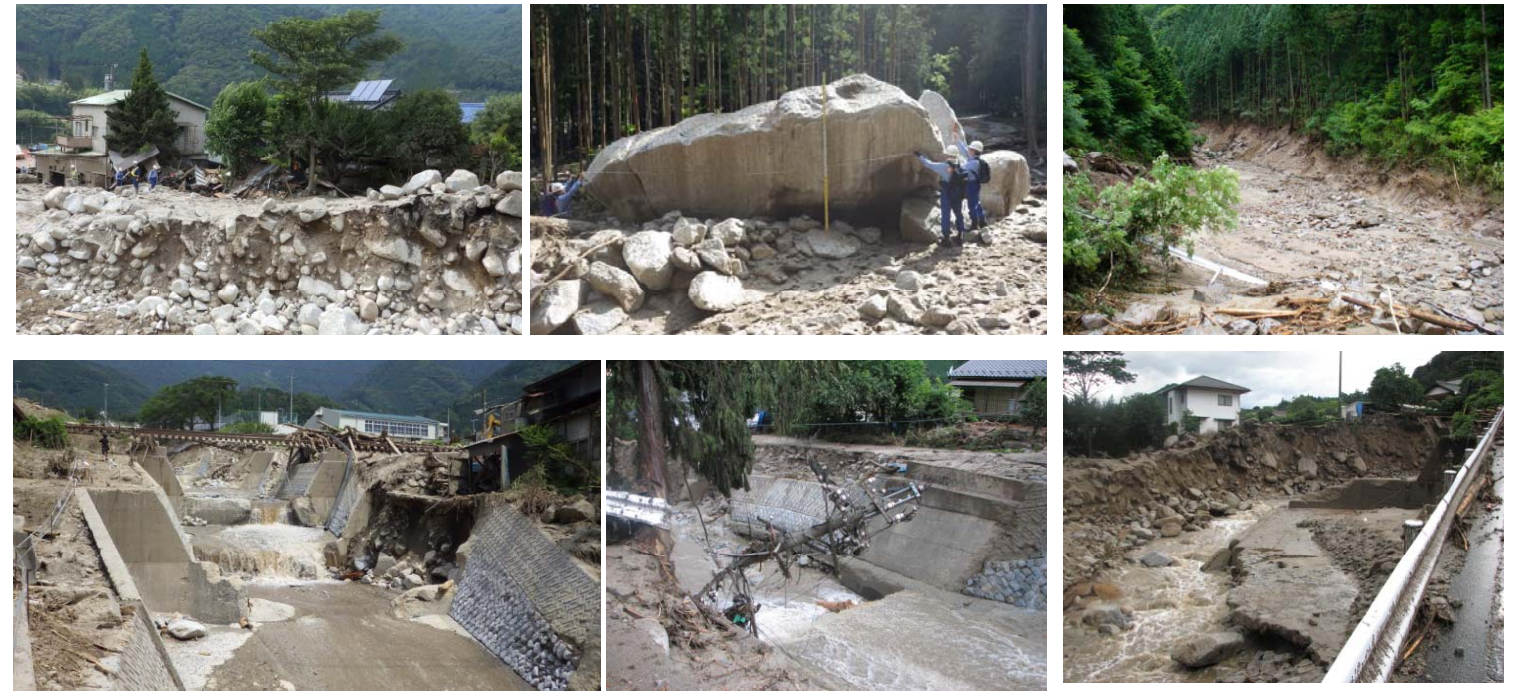
土石流発生後の砂防堰堤の状況
