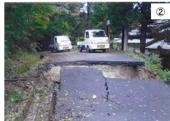
町道の変状状況
