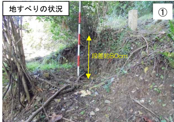
地すべりブロック上部の滑落崖
