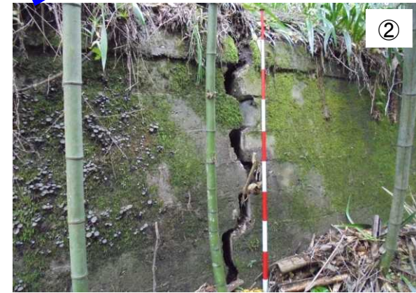
町道下の擁壁のクラック(開口亀裂 約12cm)
