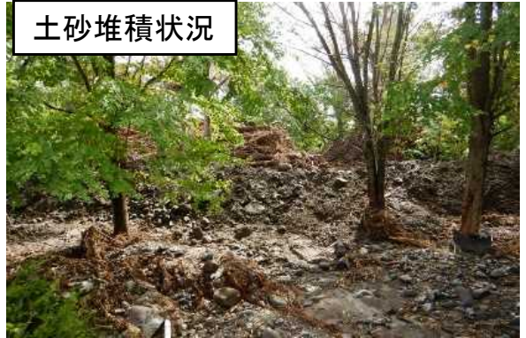
土砂堆積状況
