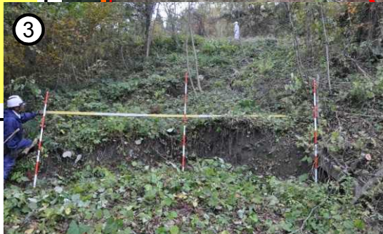
地すべりブロック下段頭部の滑落崖 【約1000cm】
