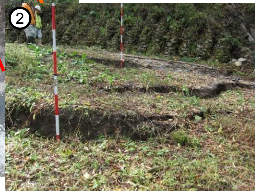
地すべりブロック下段頭部の滑落崖 【約40cm】
