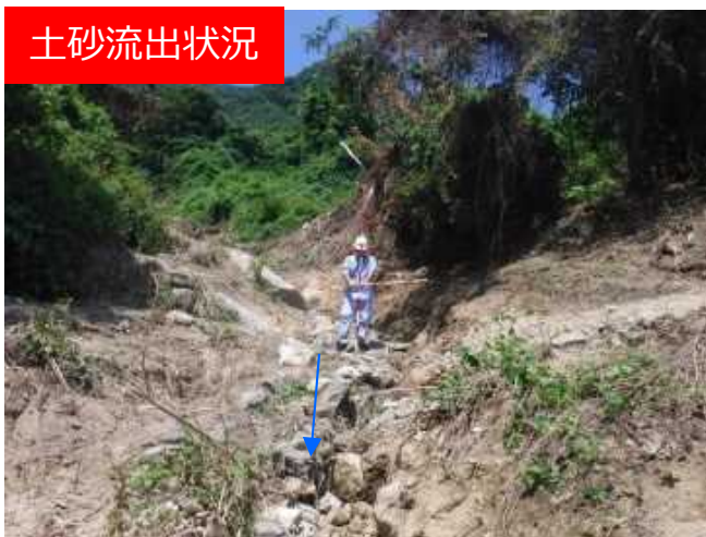
土砂流出状況
