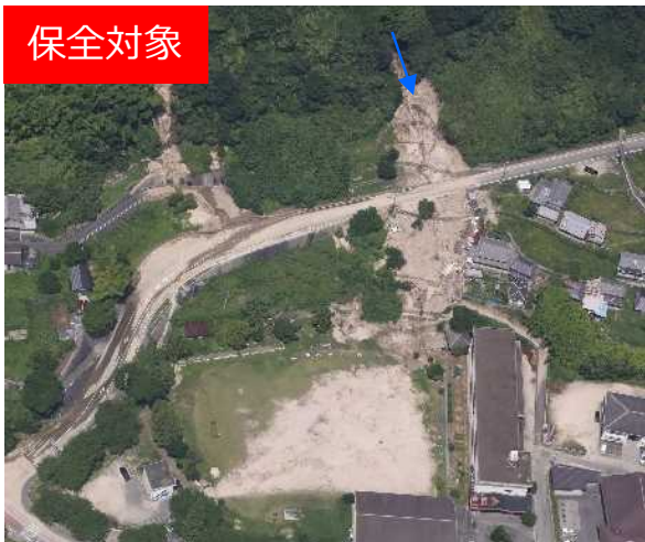
土砂流出状況
