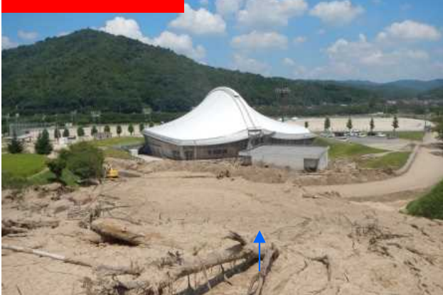
土砂流出状況
