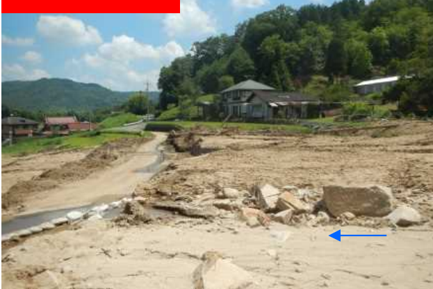
土砂流出状況
