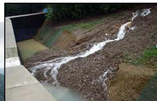
今回、砂防堰堤で土砂を捕捉
