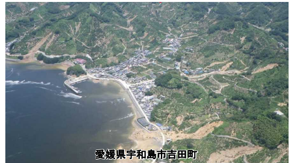
【豪雨により、多数の崩壊が発生している事例】
