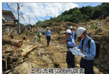
土石流被災箇所調査
