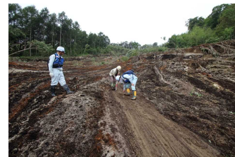
TEC-FORCE高度支援班による地上調査の実施(9/7)
