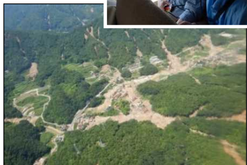
ヘリ調査（広島県呉市安浦町）
