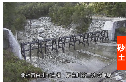
台風19号前(尾白川第三砂防堰堤)
