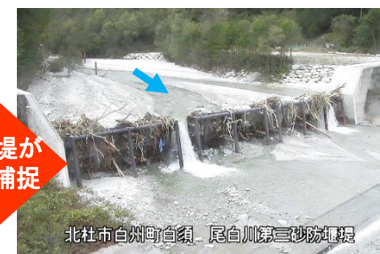
台風19号後(尾白川第三砂防堰堤)
