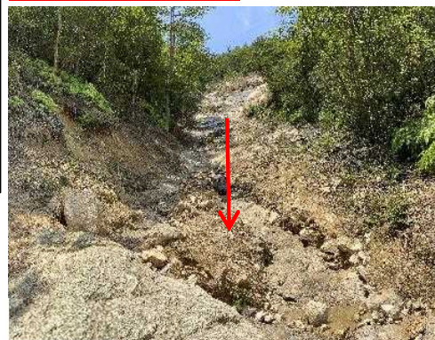
土砂流出状況
