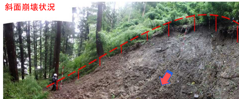
斜面崩壊状況
