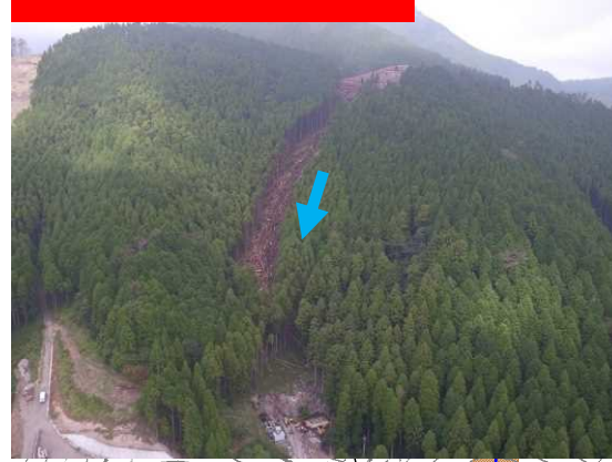
土砂・流木流出状況
