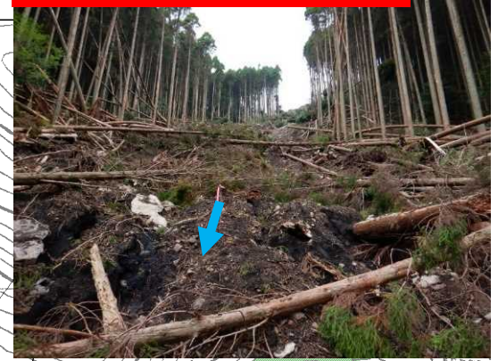
渓流土砂堆積状況
