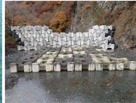
仮設堰堤完成 (平成30年11月29日撮影)
