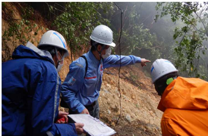
現地調査状況
