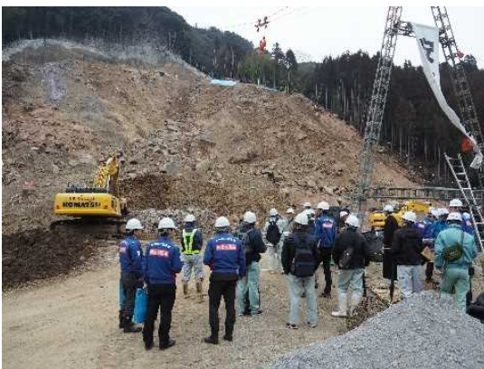
崩壊地現場の調査状況
