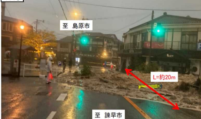
土石流の発生状況
