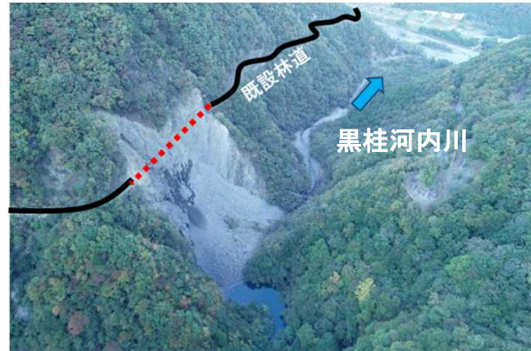
平成30年10月21日発生 の崩落状況
