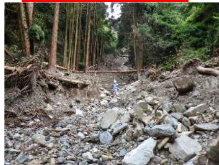
溪流土砂堆積状況
