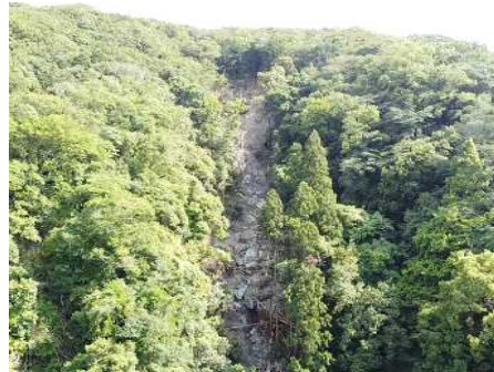
崩壊地最上部
