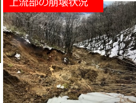
上流部の崩壊状況
