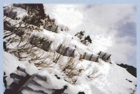
雪崩予防柵(福島県耶麻郡西金津町)
