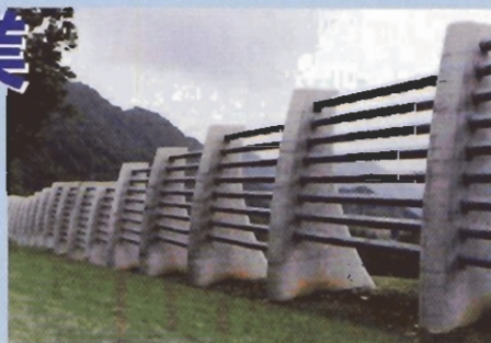
雪崩防護工(新潟県中魚沼郡津南町)
