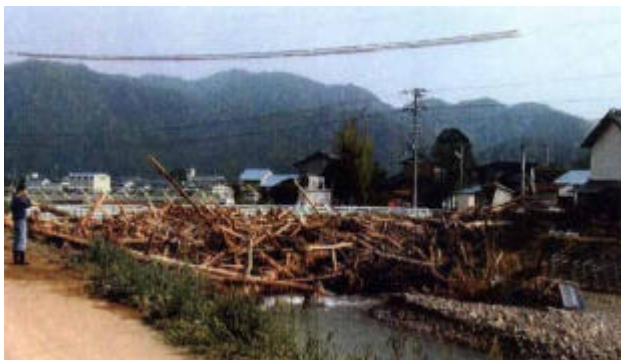
兵庫県出石町鍛福橋 (台風23号)
