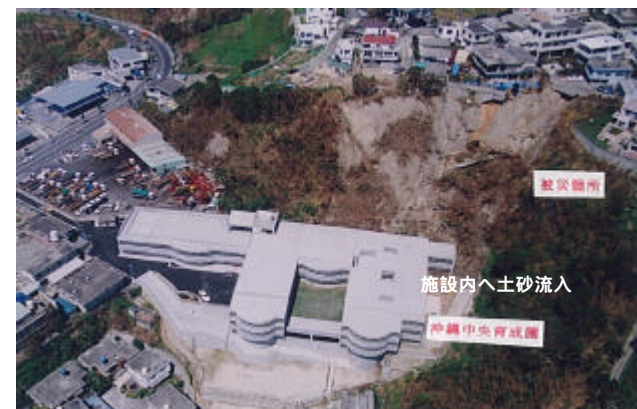
H11年9月台風18号により、知的障害者施設が被災 (沖縄県)
