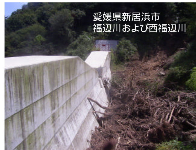
砂防えん堤が流木・土石流を捕捉
