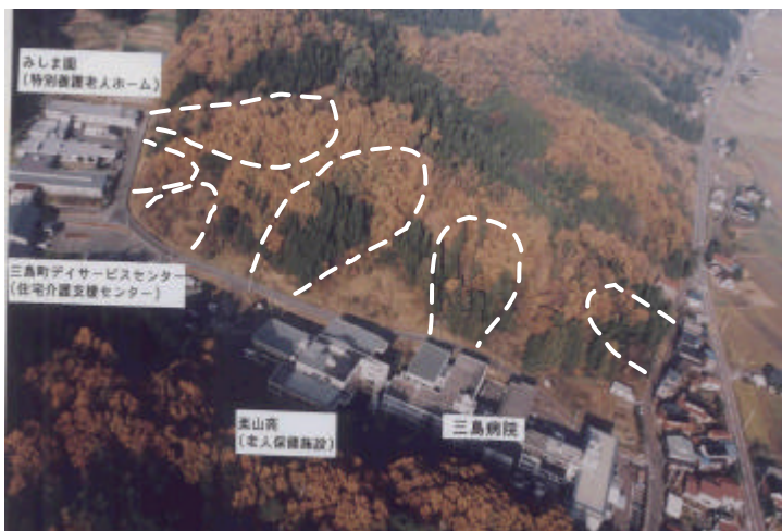
災害時要援護者施設集中地区における地すべり対策（新潟県）
