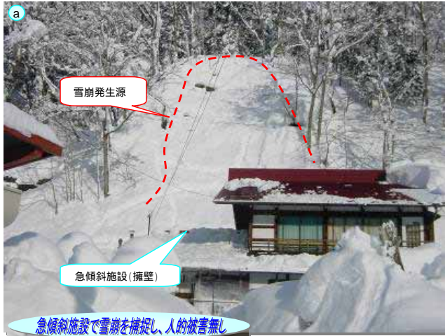
平成17年12月24日7時30分発生 岐阜県飛騨市稲越字柳ヶ瀬地内
