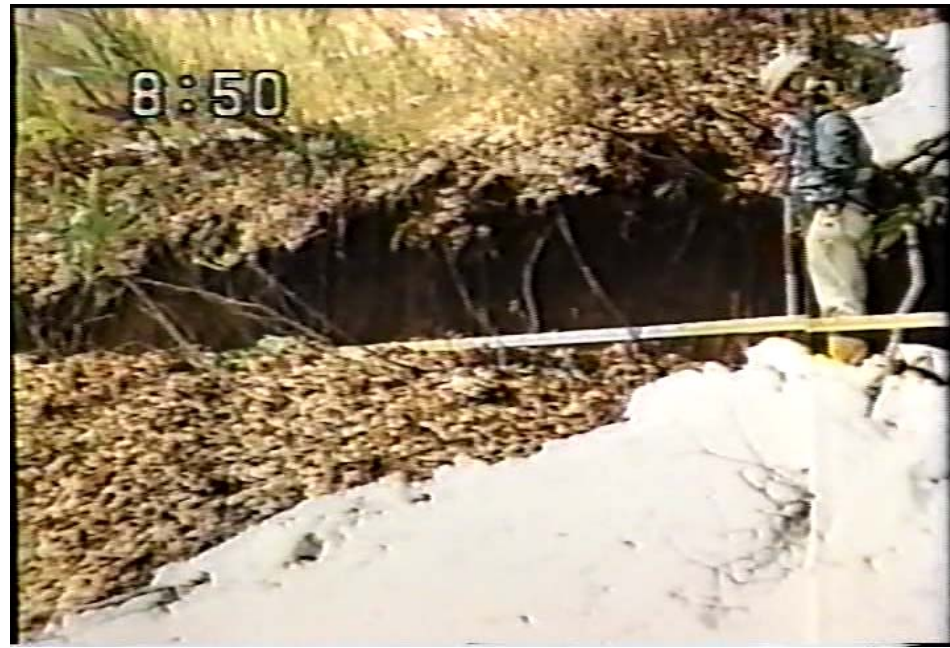
斜面のひびが進行してできた段差
