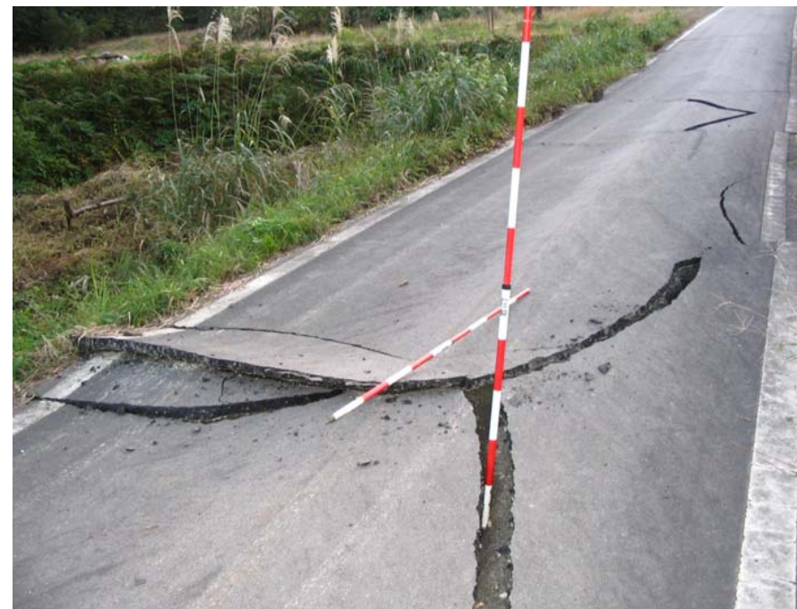
舗装道路のひび
