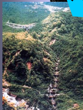
泥谷（立山砂防事務所）
