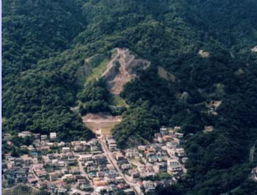
焼ヶ原えん堤（六甲砂防事務所）
