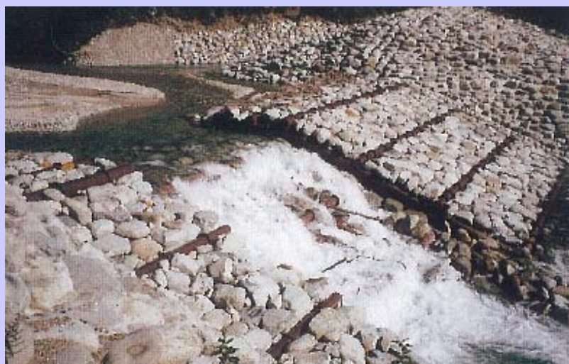
左俣谷床固工（神通水系砂防事務所）
