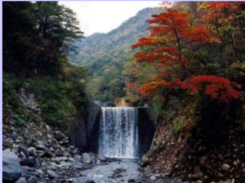
釜ツ沢下流砂防えん堤（日光砂防事務所）
