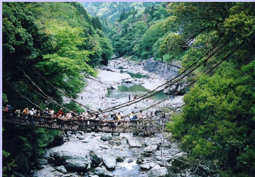
善徳護岸（四国山地砂防事務所）
