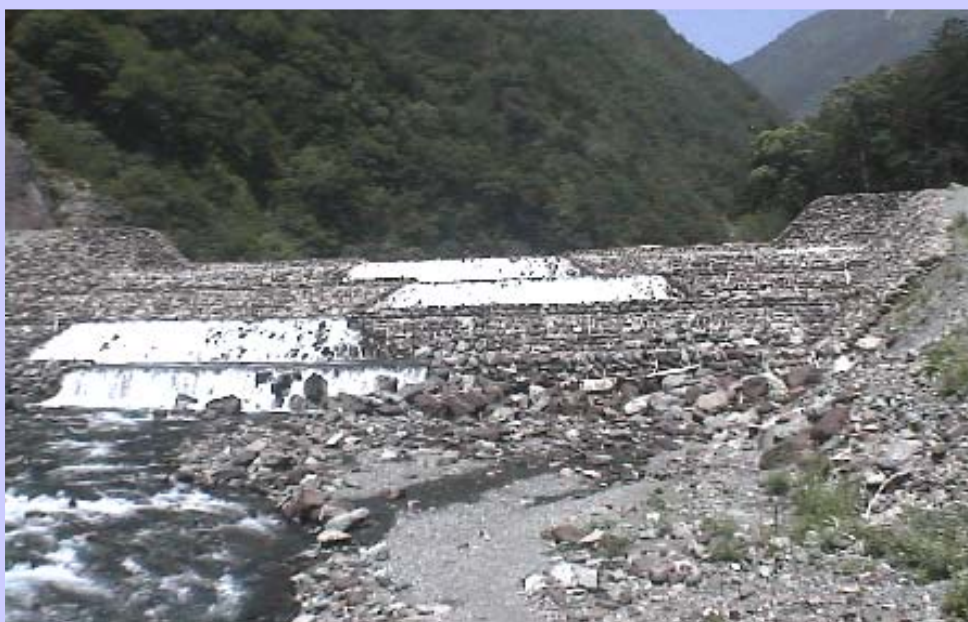
広河原第二砂防えん堤（富士川砂防事務所）
