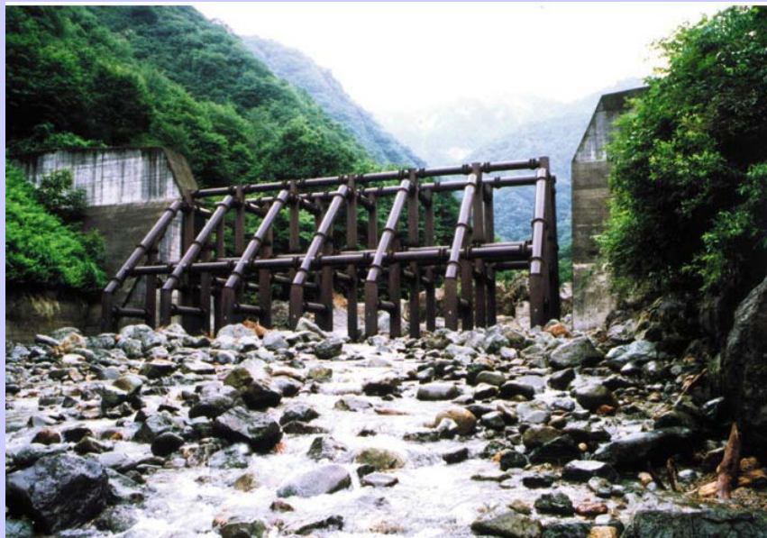
五十沢砂防えん堤 (湯沢砂防事務所)
