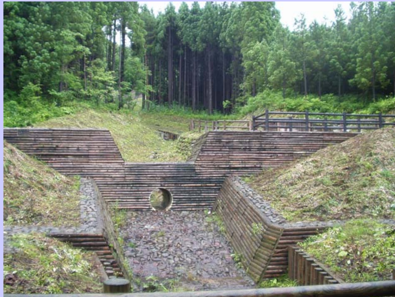
橋場安栖沢第1床固工 (岩手河川国道事務所)
