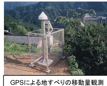
GPSによる地すべりの移動量観測
