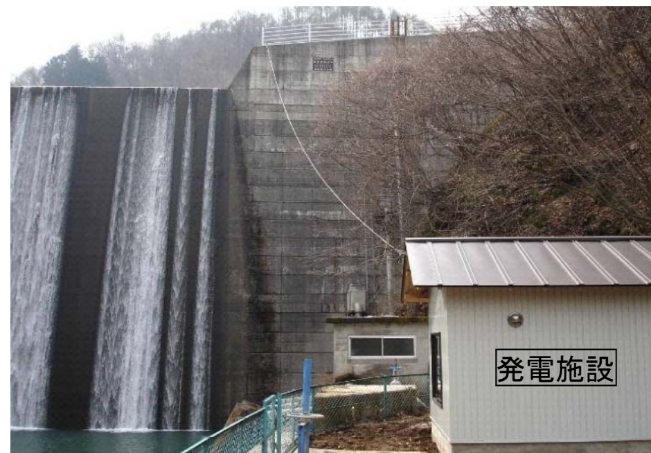
浅刈砂防えん堤（長野県長野市）
