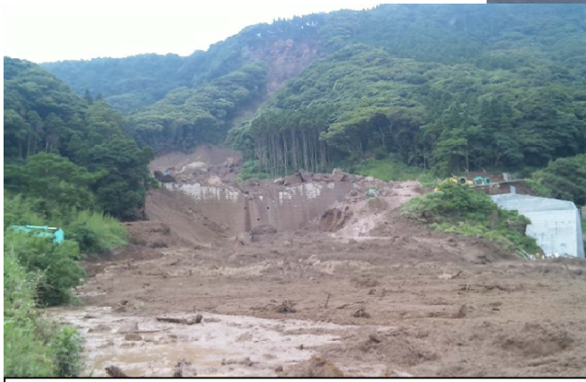
既設の砂防堰堤で土石流を捕捉
