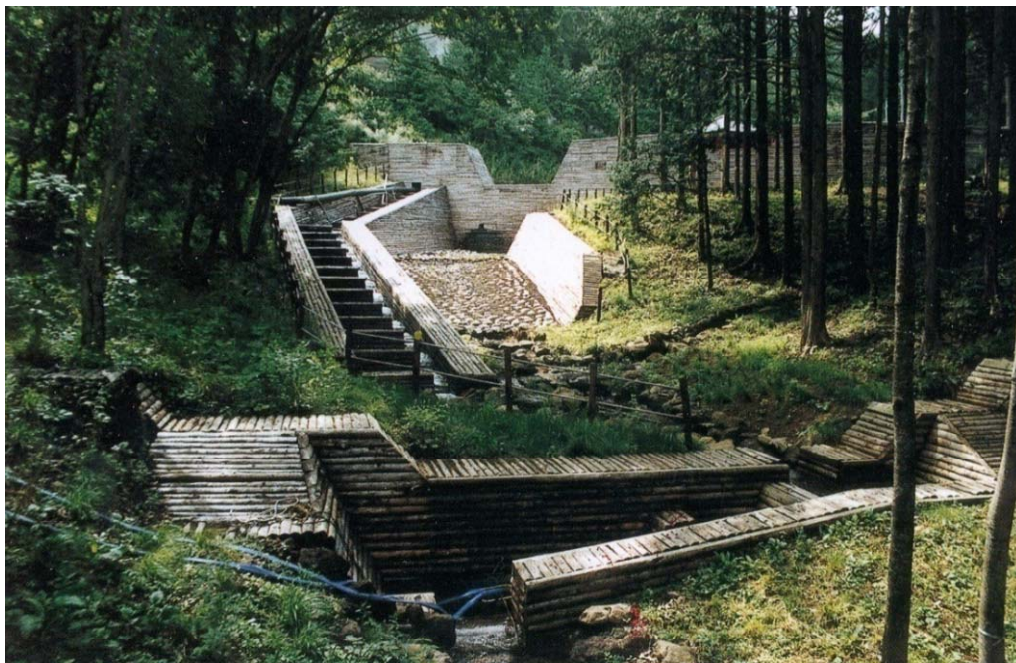
樋ノ口沢砂防堰堤（長野県長野市）
