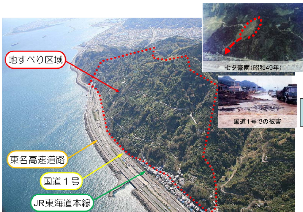
由比地区地すべり(静岡県静岡市清水区)
