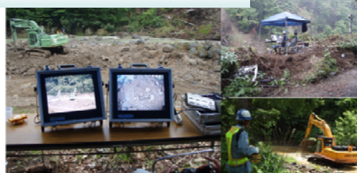
危険な区域での無人化施工
