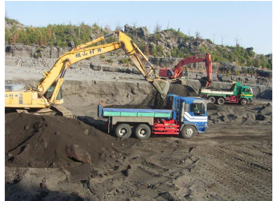
河道に堆積した土石等の除石(桜島)
