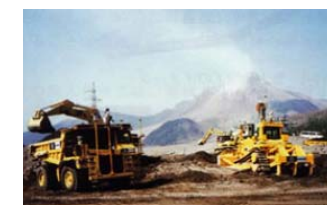
無人化施工による緊急対策工事
