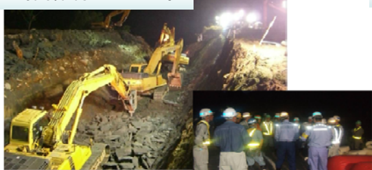
24時間体制の応急工事
